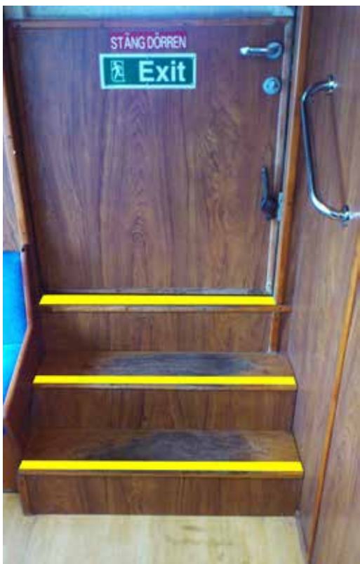
Trappsteg akter, markeras med gul antihalkmaterial
