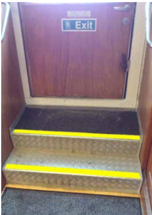
Ingångstrappa, markeras med svart eller gul antihalkmaterial
