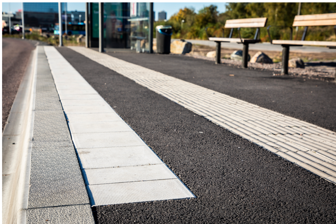
Figur 4. Kontrastmarkering av plattformskanter. Foto: Eddie Löthman, Västtrafik.
