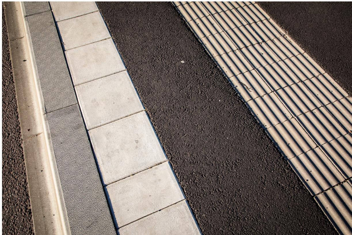
Figur 7. Taktila markeringar och ledstråk på hållplatser. Släta plattor längst kantstödet, vänster i bild är kontrastmarkering. Sinusplattorna, höger i bild, är ledstråket. Foto: Eddie Löthman Västtrafik
